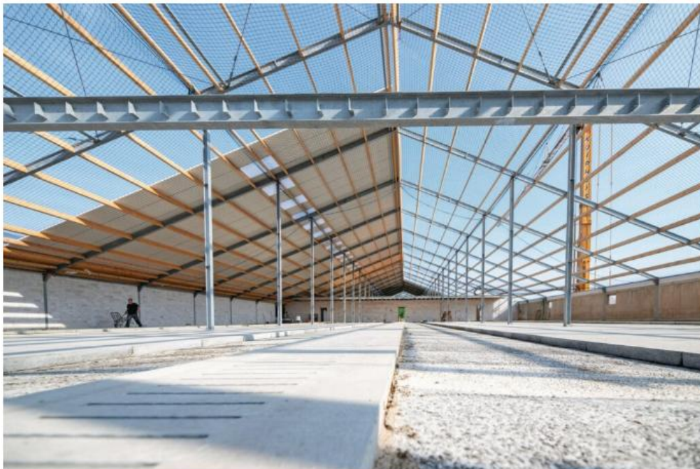
Bouwkosten zijn de afgelopen jaren sterk gestegen. Sinds corona en de Oekraïne-oorlog zijn prijzen van bouwmaterialen en de lonen snel opgelopen en die blijven ook dit jaar hoog. Foto: Michel Velderman
